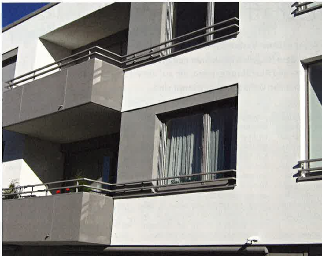
3 Objekt »Hüttenstraße«, Kaufbeuren. EPS WDVS.
